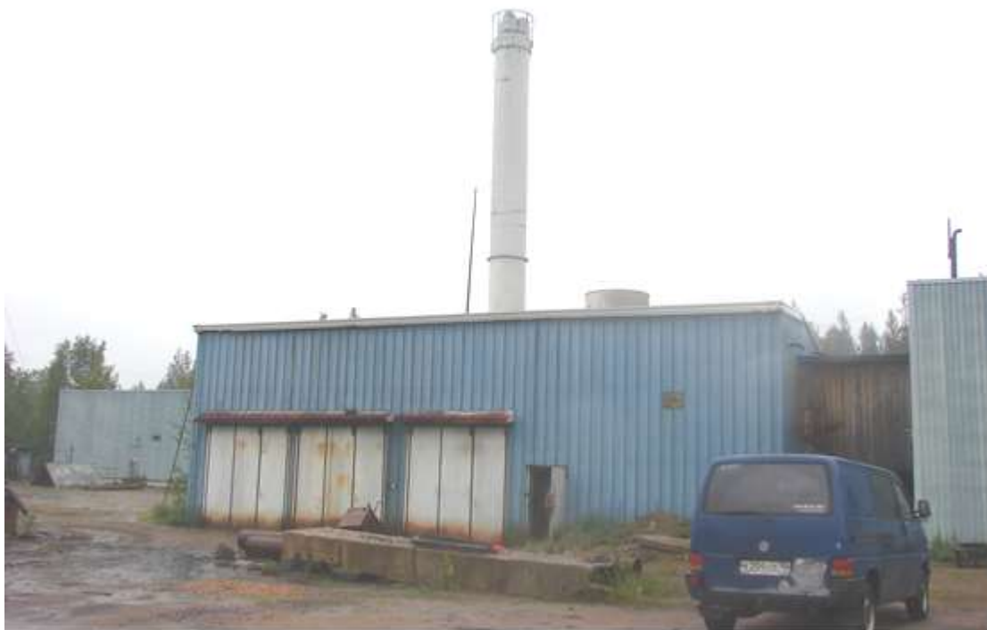
Рисунок 1.2.2.1 – Котельная ОАО «ЛПХ»
